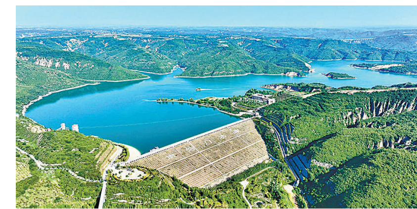
整改后,南沟门水库水清岸绿,群众饮水安全有了保障。
