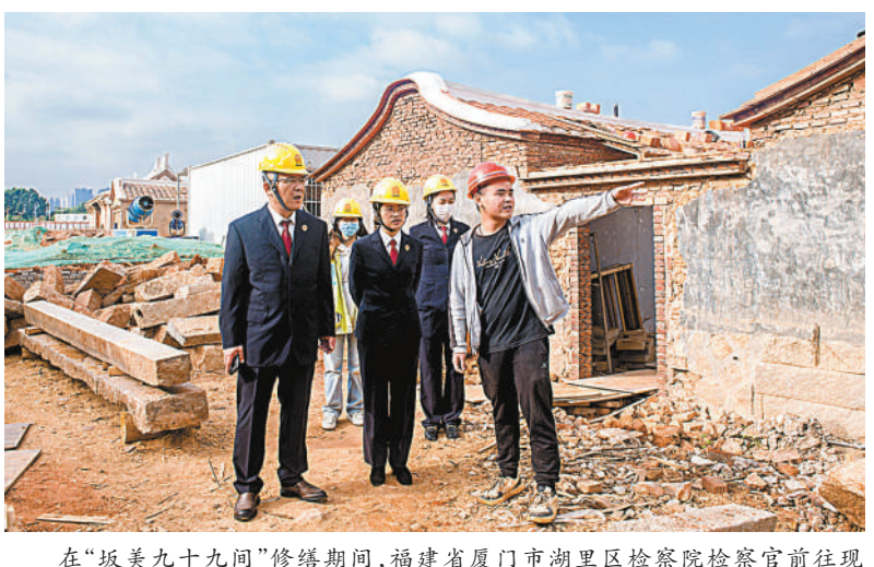
在“坂美九十九间”修缮期间，福建省厦门市湖里区检察院检察官前往现场查看整改情况。
