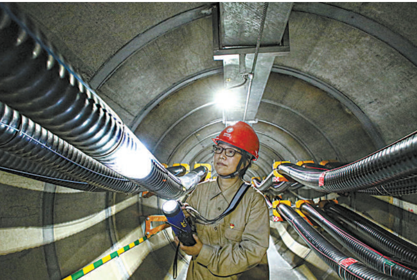
何光华在220千伏红旗变电电缆隧道巡视。
