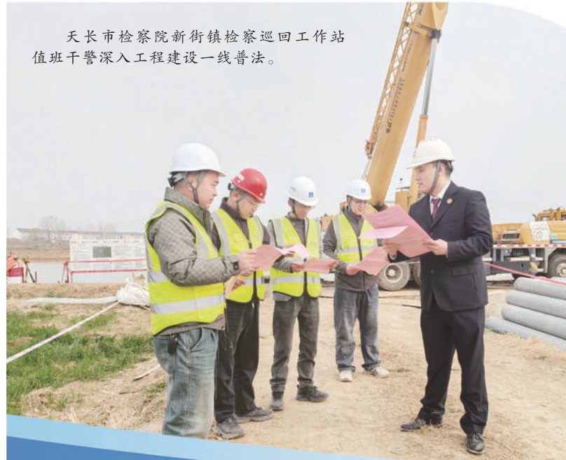
天长市检察院新街镇检察巡回工作站值班干警深入工程建设一线普法。
