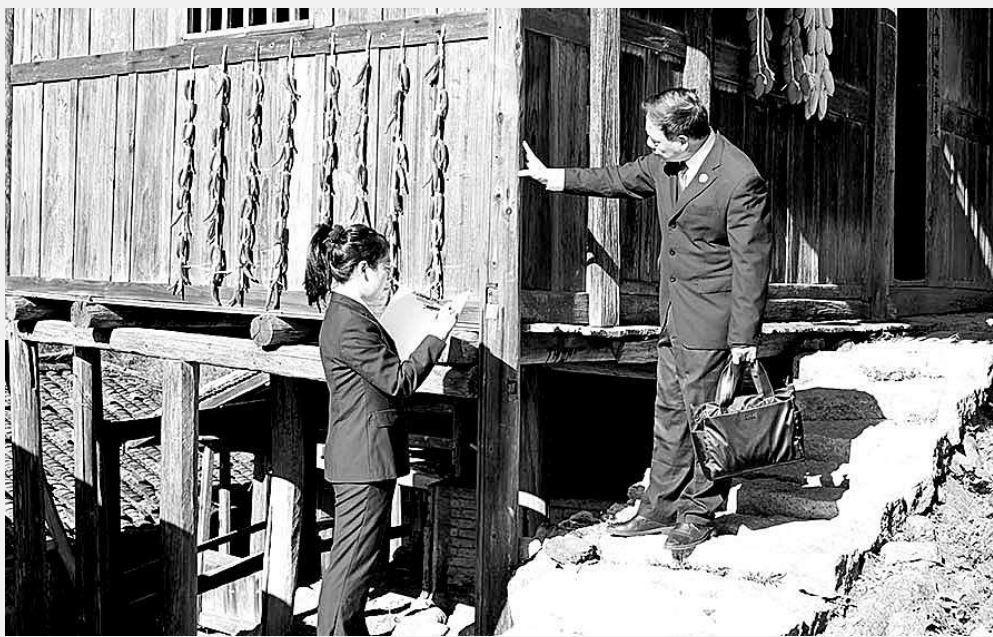
11月28日,福建省泰宁县检察院干警前往泰宁县大龙乡老虎际古村落,就古村落修缮行政公益诉讼检察建议落实情况跟踪回访,督促检察建议落地见效,为进一步推进传统古村落传承与保护贡献检察力量。
