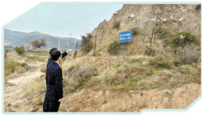
今年10月,山西省兴县检察院干警在魏家滩镇北齐长城遗址对整改效果进行回访。
