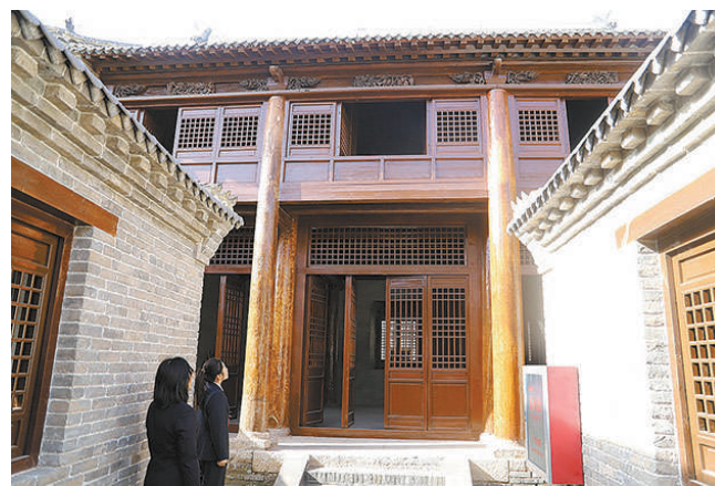
李家当铺院整改后
