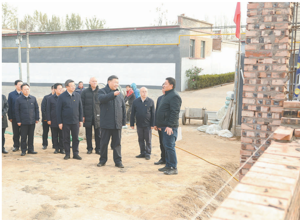
11月10日，中共中央总书记、国家主席、中央军委主席习近平在北京、河北考察灾后恢复重建工作。这是10日下午，习近平在河北保定涿州市刁窝镇万全庄村房屋重建施工现场考察。
