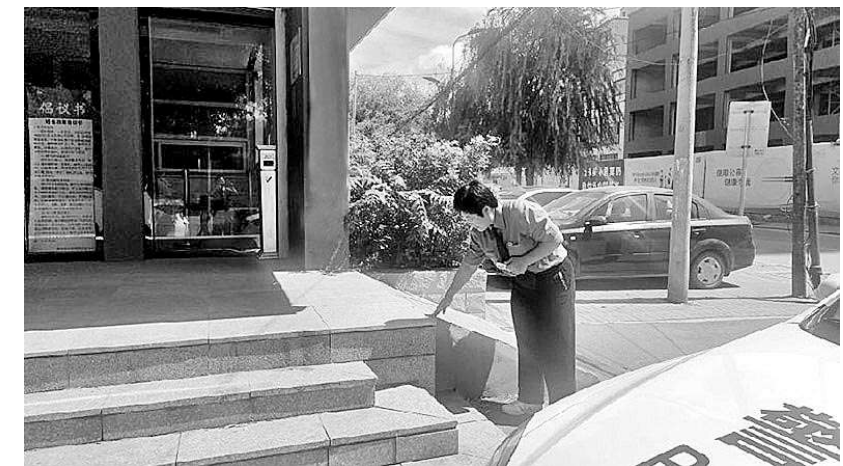
新市民某窗口办事单位门前的无障碍坡道非常陡峭。
