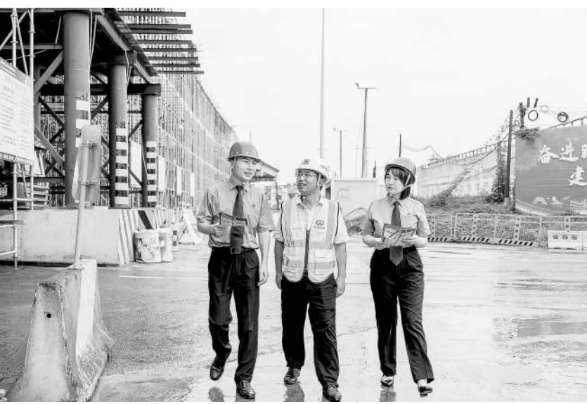
近日,江苏省无锡市惠山区检察院检察官走进辖区重点交通设施建设现场,向施工单位负责人讲解最高检“八号检察建议”的制定背景、主要内容及意义,提醒企业落实安全生产主体责任,筑牢安全生产防线。 本报通讯员刘洁摄
