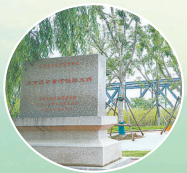
山东省济南泺口黄河铁路大桥南侧纪念碑修缮后,面貌一新。
