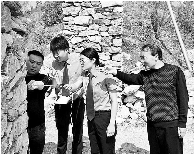
检察官实地调查楚长城遗址墙体受损情况。
