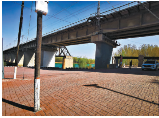
整改后的滦河铁桥景区
