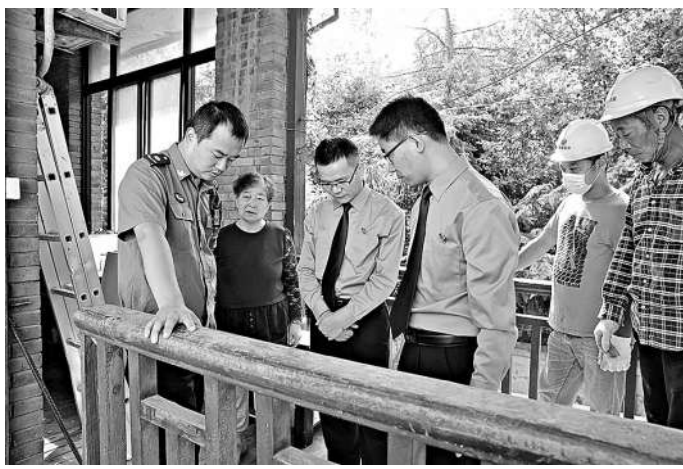
今年10月27日,检察人员对拆除违建工作进行现场监督。
