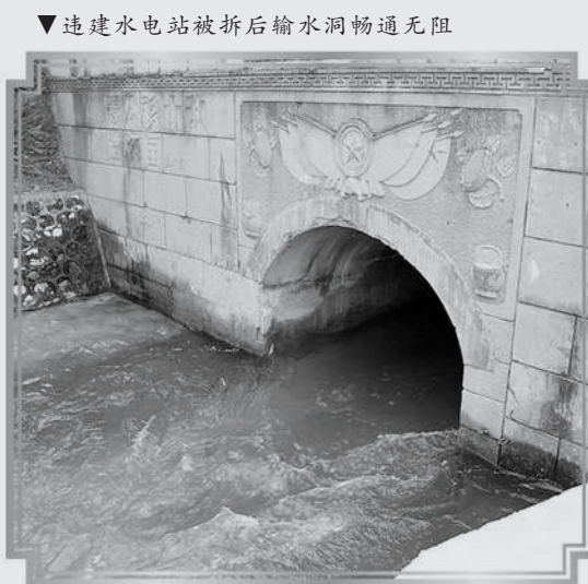
▼违建水电站被拆后输水洞畅通无阻
