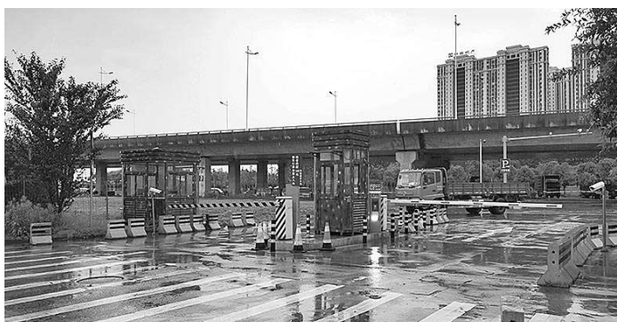
违建停车场紧邻城市高架桥
