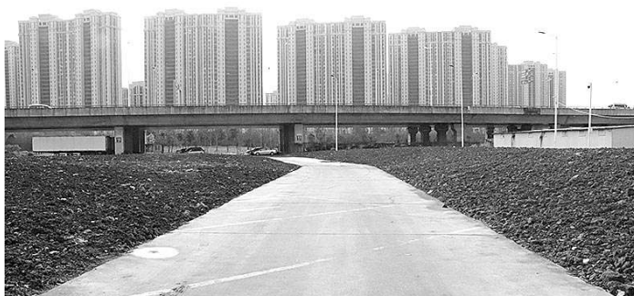
被占用的土地已恢复原状
