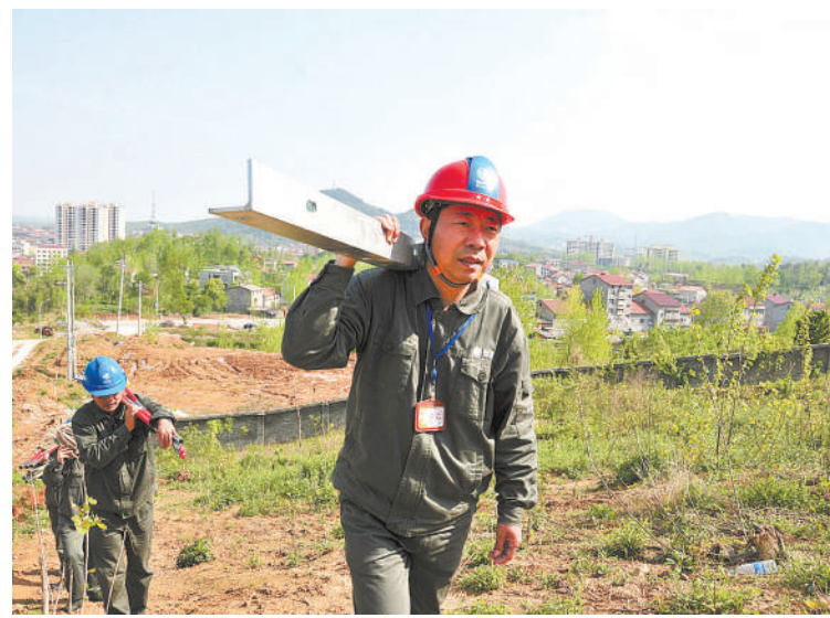
曾凡平扛着施工材料上山，架设超高压输电线路
