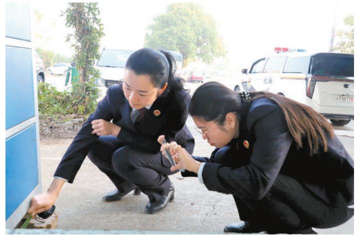
2026年2月,湖南省汨罗市检察院检察官现场测量共享换电柜安装间距与离地高度,核查是否符合相关技术规范。
