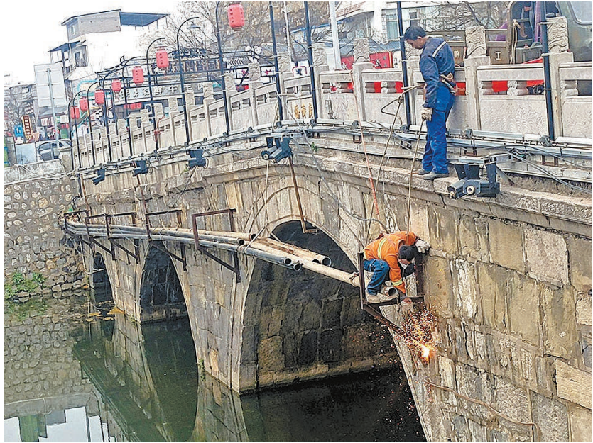
2025年1月26日，在河南省洛阳市瀍河回族区检察机关的监督推动下，施工人員正依法依规对黄公广济桥桥体管道实施拆除作业。
