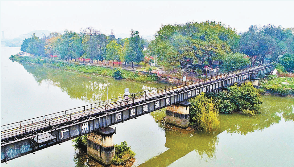
粤汉铁路流溪河大桥遗址。
