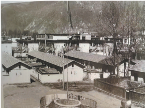
1980年的西藏自治区检察院建的五排平房(干警宿舍和办公室)。
