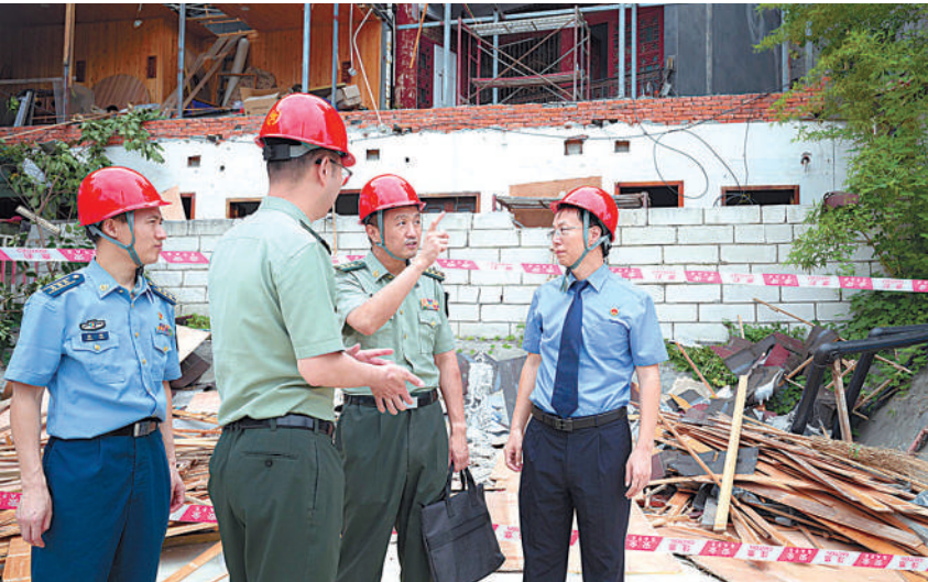
成都市青羊区检察院、成都军事检察院检察官现场监督拆除涉军违建。王雪摄
