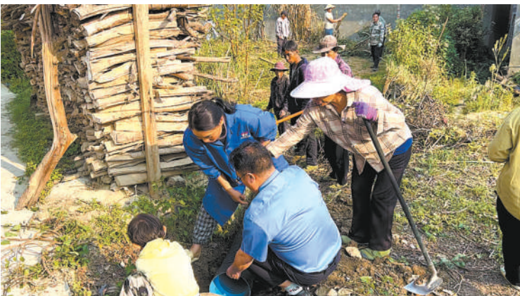
泸水市检察院检察官到修路现场了解情况。
