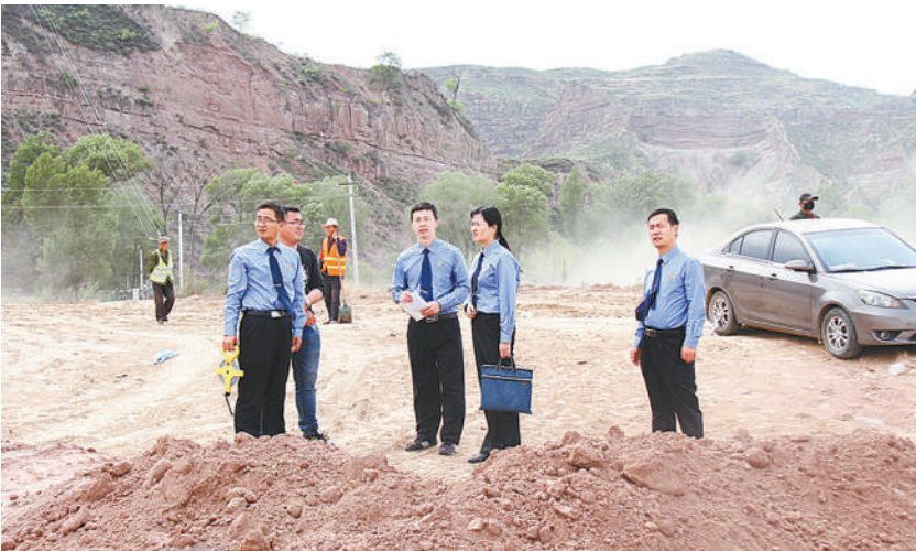
2024年6月,陕西省府谷县检察院干警到该县孤山川污水及河道治理工程施工现场进行实地探查。
