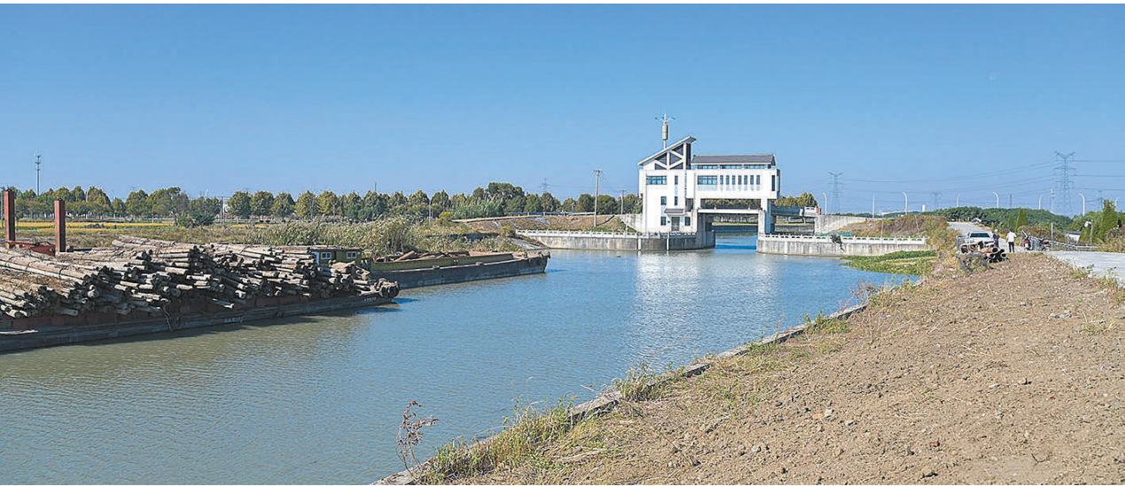
江苏省无锡市惠山区境内,大运河某河浜里的工程泥浆被全部清理完毕,河道恢复畅通。
