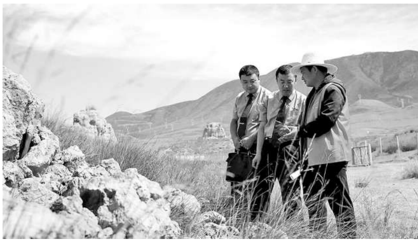
刘忠(中)和同事在文保员陪同下,查看乌鞘岭长城风化坍塌情况。
