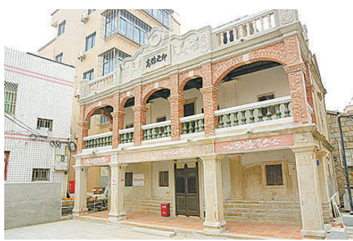
修缮后的盐兵楼
