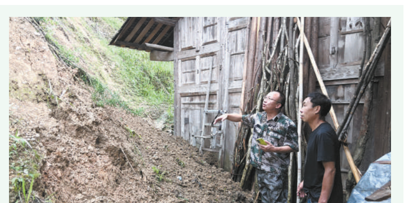
日前，贵州省黄平县检察院派员驻浪洞镇铁龙村、平磨村驻村第一书记和工作队员到地质灾害点、公路沿线查看滑坡、泥石流灾情和安全隐患，参与清淤，及时疏散村民。
