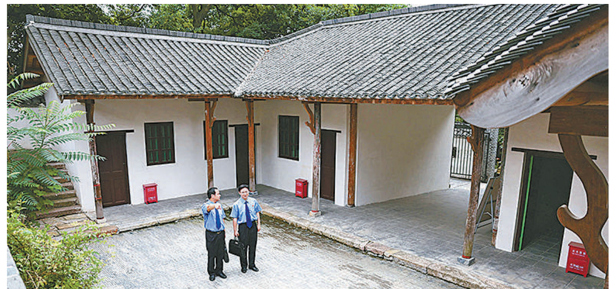
曾经墙体面破损倾斜、藤蔓植物爬上屋顶的皖江中学堂,在检察建议发出后得到有效整治。 本报记者张哲摄
