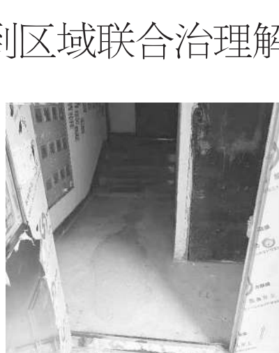
整改后:楼道内污水清理完毕,污水外溢问题圆满解决。
