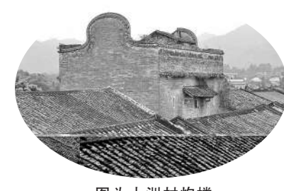
图为大洲村炮楼
