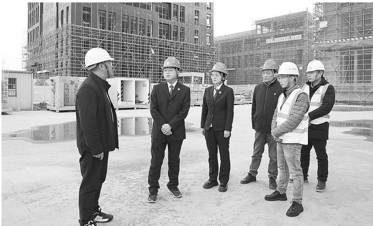
安徽省怀宁县检察院检察干警前往该县马庙纸塑产业园工地,现场了解特种作业人员持证上岗情况。
