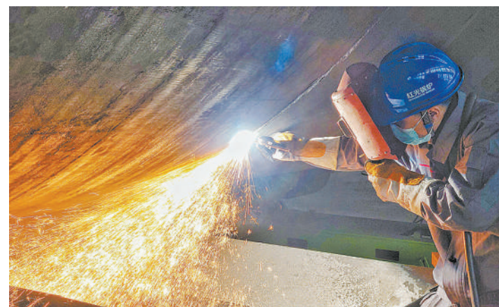
周晓龙在公司车间进行焊接作业。
