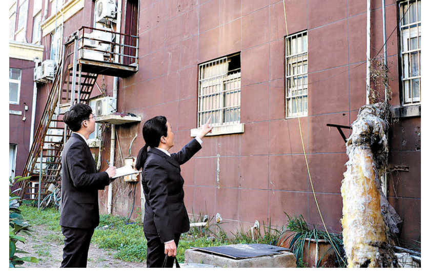
祥符区检察院检察官排查小区存在的消防安全隐患。
