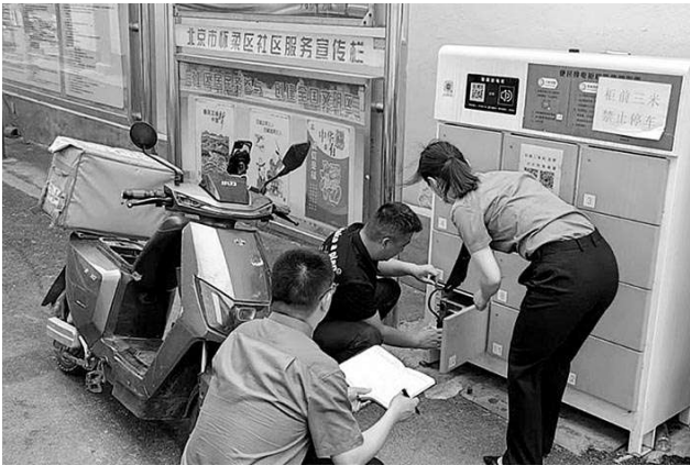
怀柔区检察院检察干警针对换电柜不符合散热距离等损害公共利益情形进行现场调查核实。
