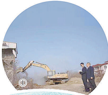
①:河南省浙川县检察院检察官查看违建别墅拆除情况。
