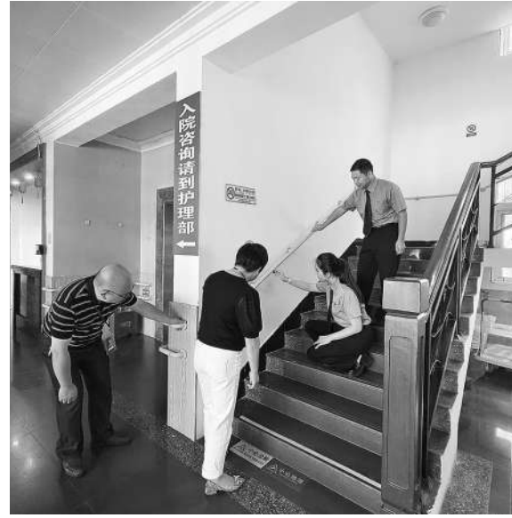
检察官回访时看到整改后全部装上了无障碍设施。
