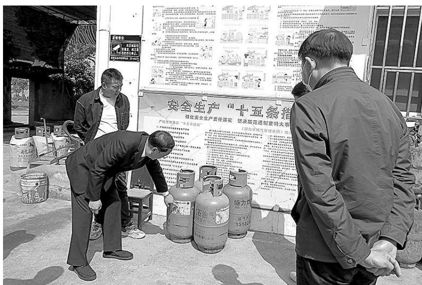
日前,湖北省应城市检察院推动相关单位开展保障燃气安全检查活动。相关单位对个别气站存在废弃液化气罐存放不规范、安全标识标牌不醒目等问题进行监督整改。
