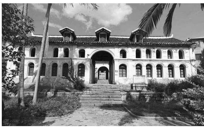
整改后的马二元帅府全貌
