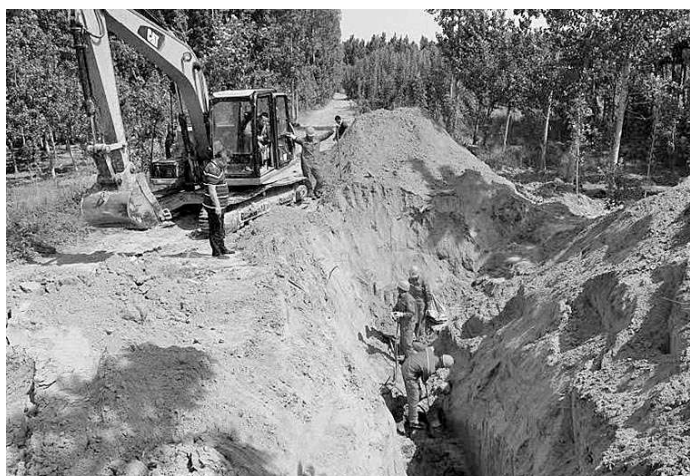
涉案废弃油管拆除现场
