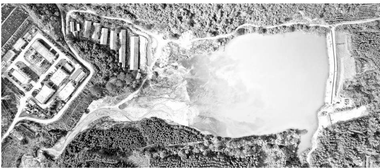
上图:富川县大源冲水库航拍图。
