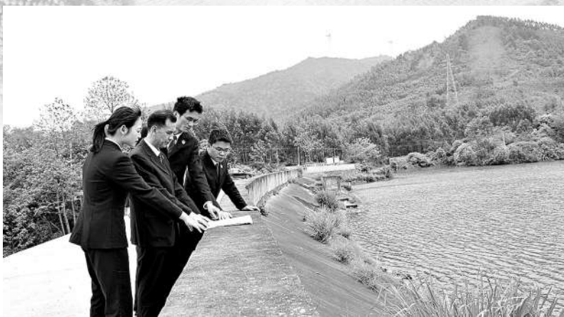
柳州铁路运输检察院办案组到大源冲水库进行现场勘察。杨仲超摄
